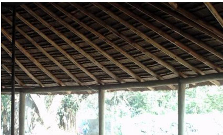
Figura 6 - Vigas de madeira com seção circular.
