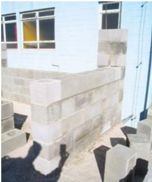
Figura 91 – Esquema de amarração corrente dentada.
