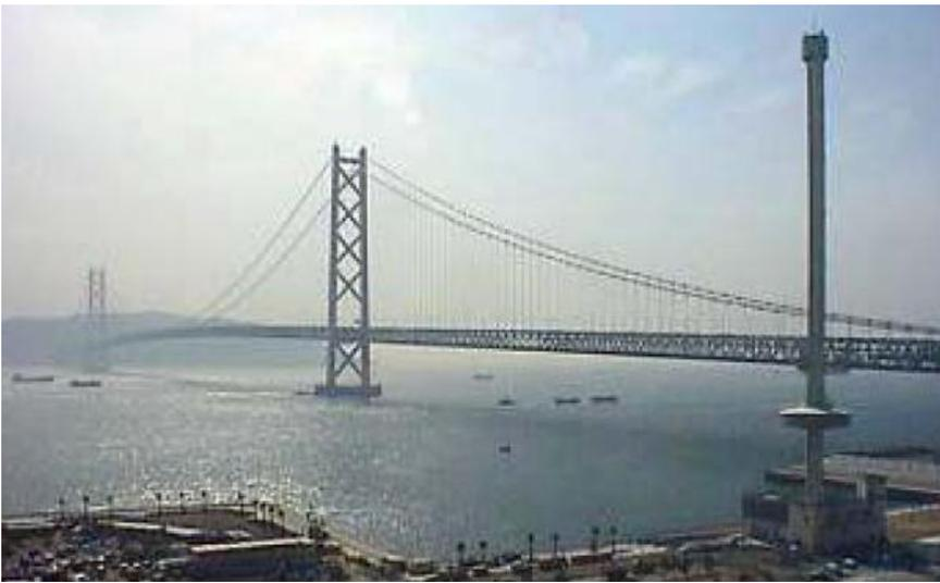
Figura 65 - Ponte Akashi Kaikyo: Ponte pênsil com tirantes verticais e tabuleiro com estrutura treliçada.
