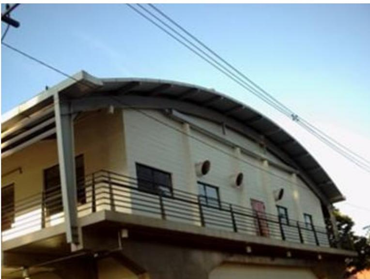
Figura 62 – Arco parabólico biapoiado.
