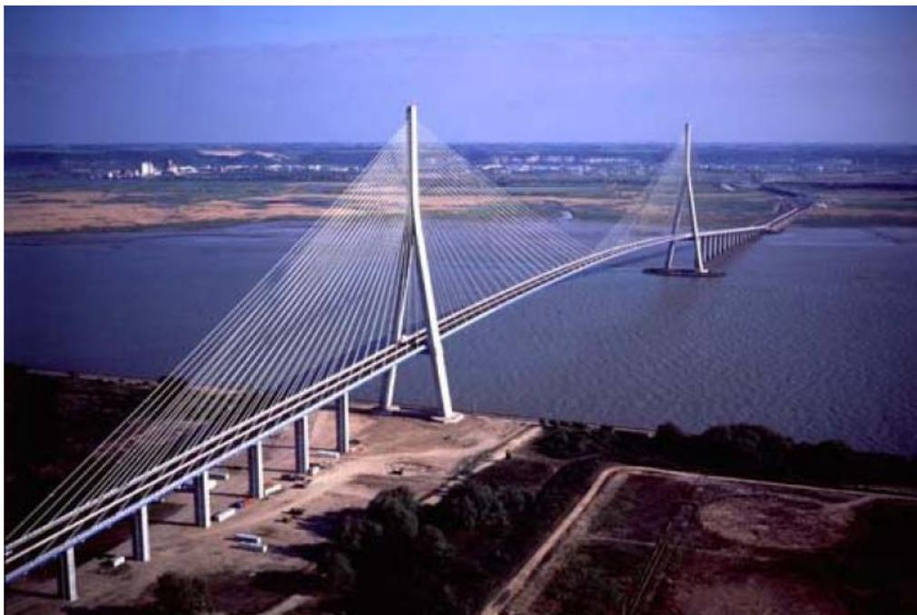
Figura 67 - Ponte da Normandia: Ponte estaiada com duas torres. ([www.matsuo-bridge.co.jp](http://www.matsuo-bridge.co.jp)).
