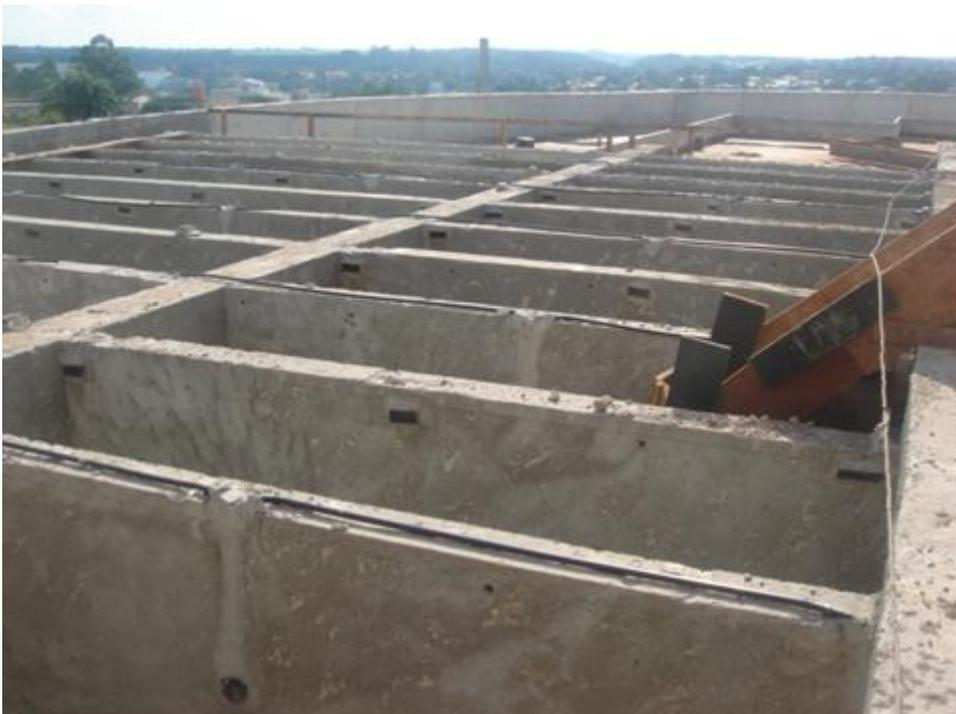
Figura 40 – Grelha ortogonal constituída de vigas de concreto armado.
