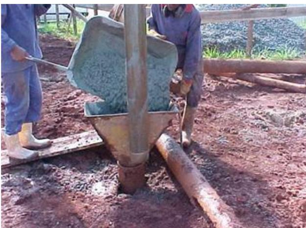
Figura 81 - Concretagem das estacas.
