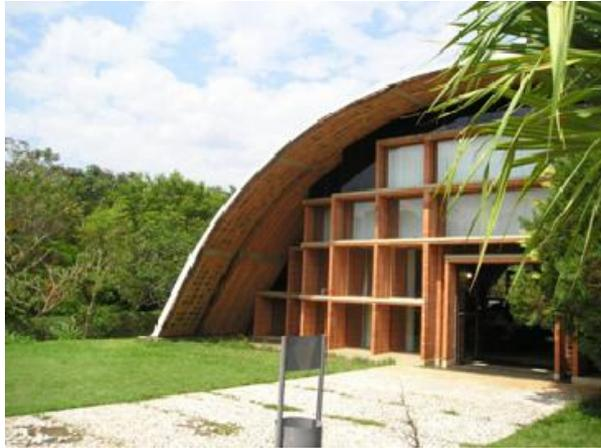
Figura 75 – Casca cilíndrica da casa do lago.
