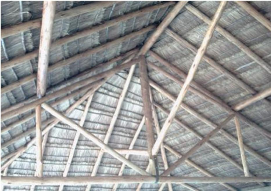
Figura 29 - Tesoura de madeira triangular em duas águas.
