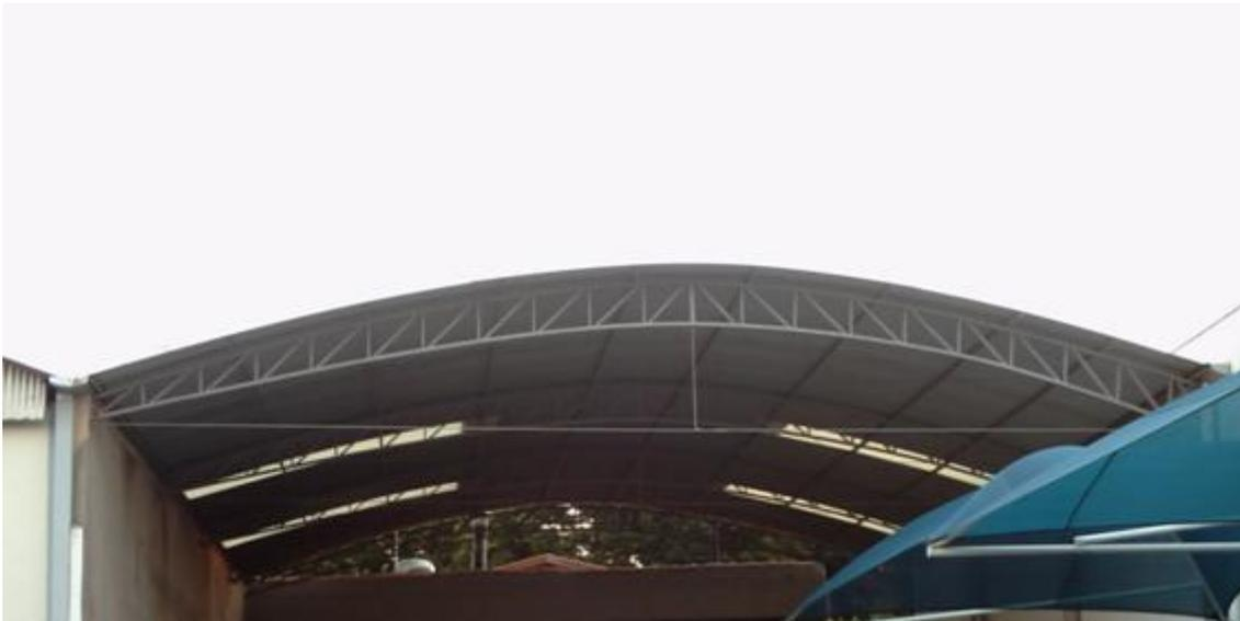
Figura 61 – Arco treliçado atirantado.
