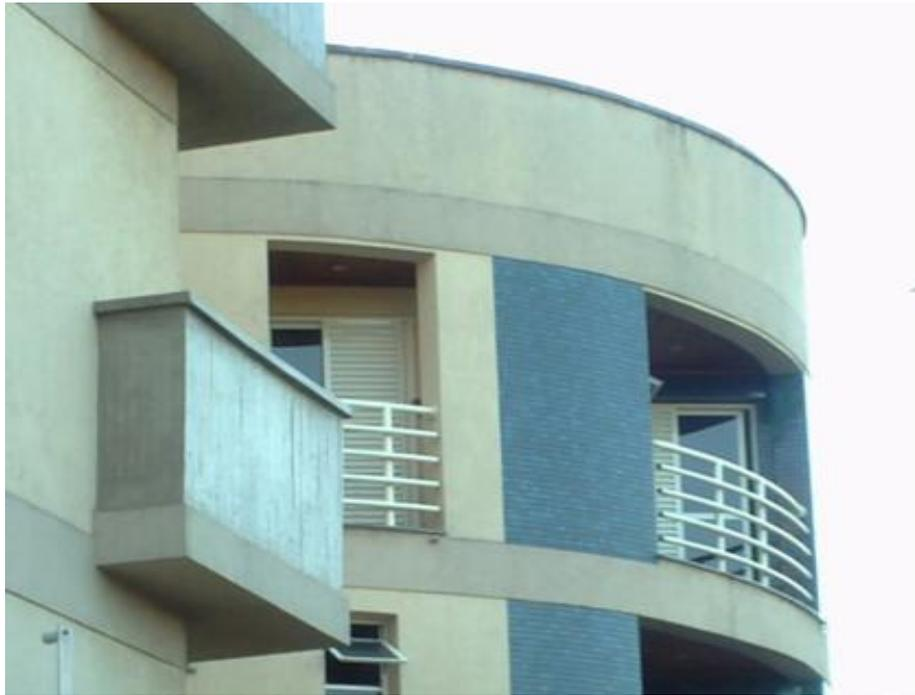
Figura 7 – Viga balcão em concreto armado.
