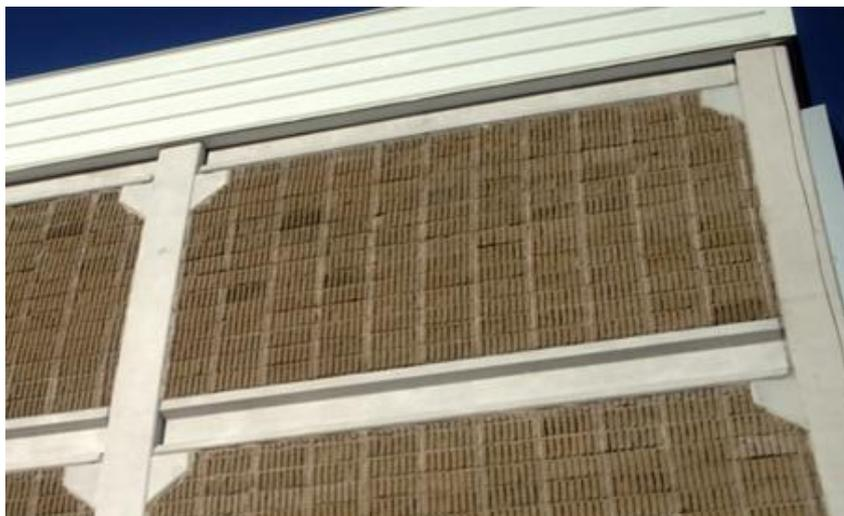
Figura 5 – Vigas pré-moldadas com ligações tipo pilar-pilar. Seção em I.
